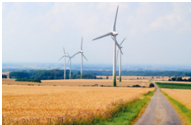
Trijų menčių horizontalios ašies vėjo elektrinių parkas Vokietijoje
